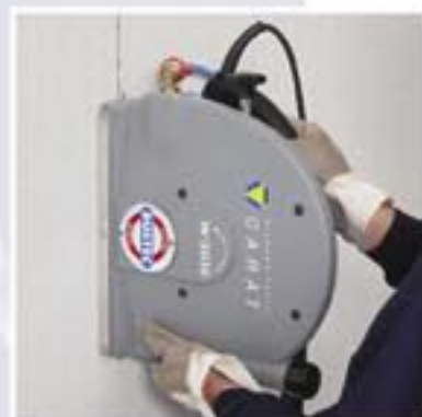
Zagen in beton....
